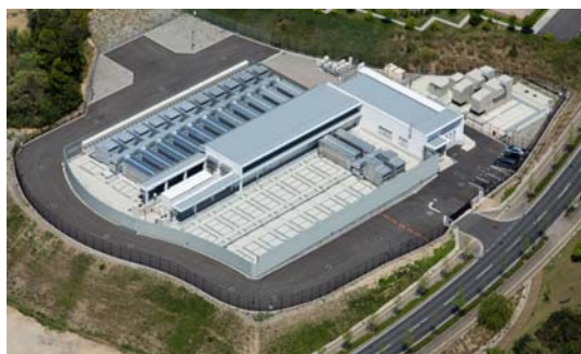
データセンターパーク外観
