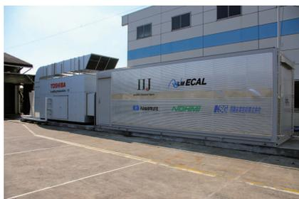
IJでは、このような状況を踏まえ、次世代のデータセンターとして次の2つの新技術に取り組んでいます。その1つは、需要の増加に応じて迅速に設備を拡張できるモジュール型データセンターの建設です。これは、従来の堅牢な建物の代わりに、運搬可能なサイズのコンテナ内にデータセンターの設備を作り込むことで実現します。もう1つは、サーバなどIT設備の冷却に外気冷却方式を導入することです。外気冷却方式は、従来のエアコンなどによる強制冷却方式に比べて、極めて少ない電力で運用でき、省エネルギーの切り札として期待されています。
